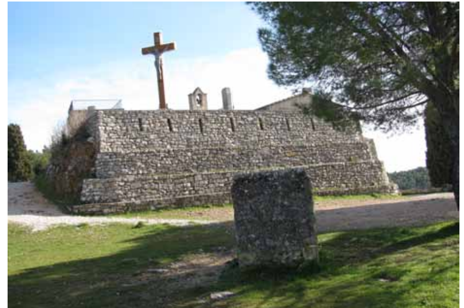
Fig.17 : Plateforme à la base de la tour. (M.Broecker)
