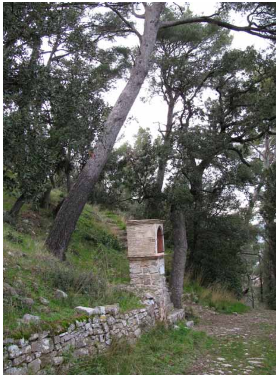
Fig.27 : Départ du chemin piéton ancien descendant vers le village neuf. (M.Broecker)
